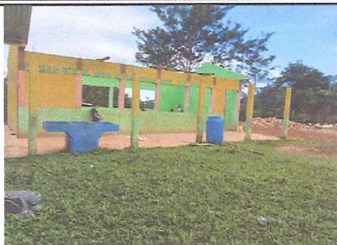
Foto 1: Desmantelado del techo a remozar
