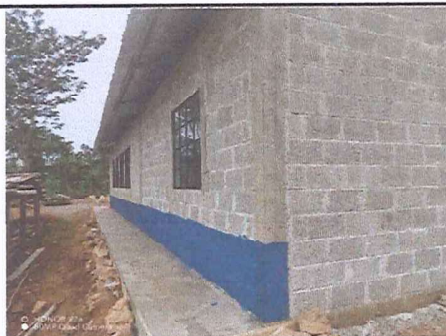
Foto 6: Fundición de banqueta
