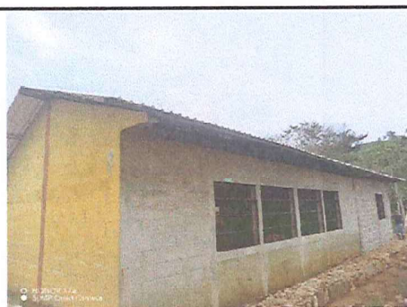
Foto 5: Colocación de ventanales
