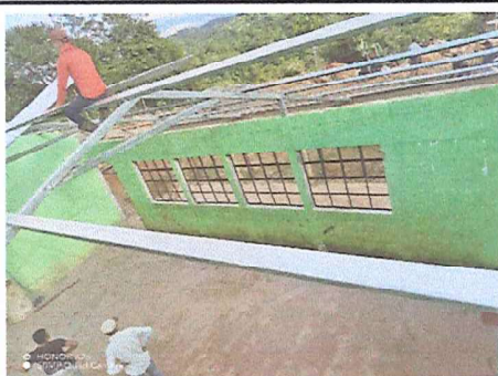
Foto 3: Colocación de la estructura de metal
