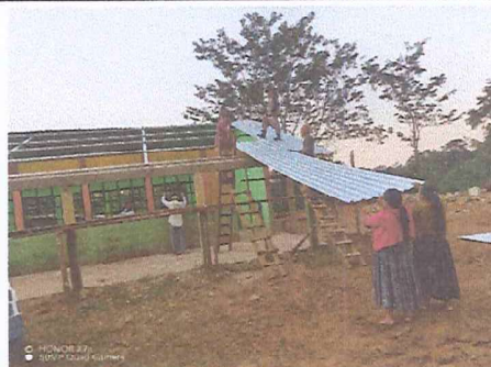
Foto 4: Instalación del techo de lamina
